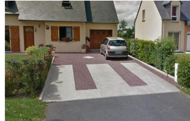
*Exemple allée semi-perméable (coefficient d'imperméabilisation = 0,5)*
